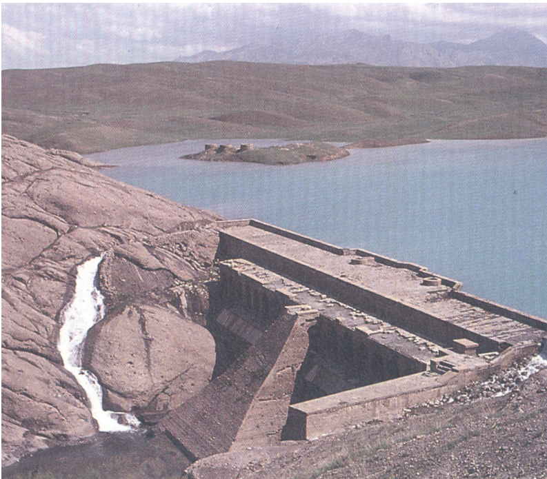
Abb. 2.7-1b: Bend-e-Fahri-man Stausee (Iran) (GARBRECHT 1987). (Mit freundlicher Genehmigung des Verlags).
