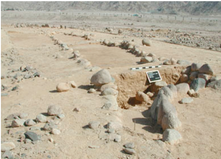
Abb. 1.11-9: Leitverwallungen aus unbehauenen Steinen und mit Lehm abgedichteten Fugen im Bewässerungsprojekt des Tell Hujayrat-al-Ghuzlan bei Aqaba (Jordanien) (mit freundlicher Genehmigung des Autors B. Heemeier).
