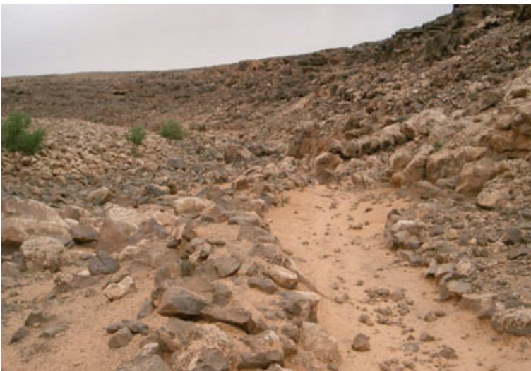
Abb. 1.11-10: Ableitungskanal für Wasser aus dem Wadi Rashid bei Jawa (Jordanien).
